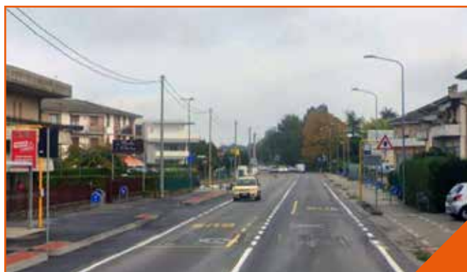
via Giovanni XXIII, asfaltatura effettuata dalla Provincia di Treviso
